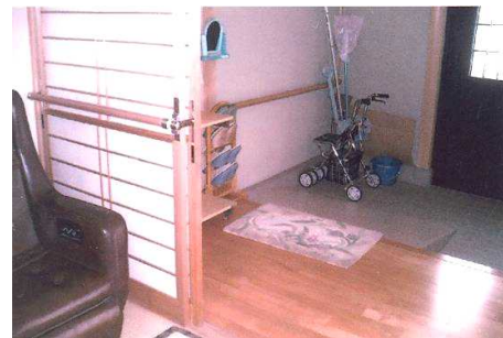
4枚戸への取り付け例(障子)ほぼ全開に戸を開けることが出来ます。
