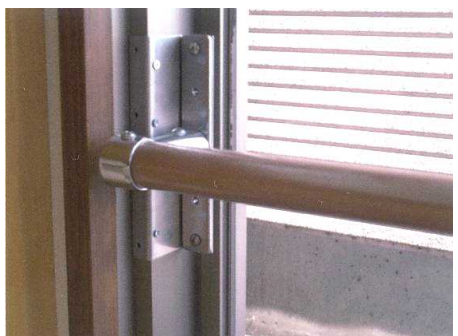
戸に合わせてブラケットを加工した例。
