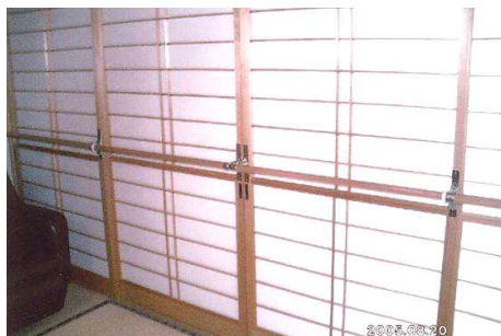
4枚戸への取り付け例(障子)ほぼ全開に戸を開けることが出来ます。
