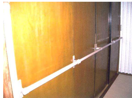
廊下一面への取り付け例。手摺りが途切れることなく取り付けることが出来ます。
