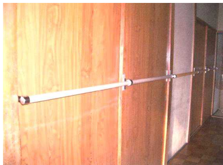
廊下一面への取り付け例。手摺りが途切れることなく取り付けることが出来ます。
