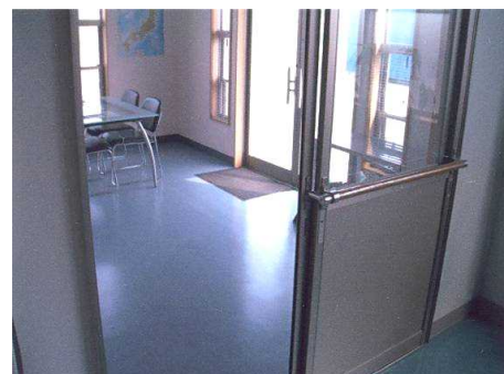
サッシにも取付け可能です。手すりを外すことなくスムーズに開閉できます。
