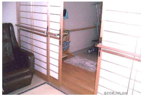
4枚戸への取り付け例(障子)ほぼ全開に戸を開けることが出来ます。
